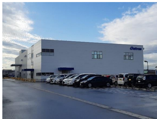
中部第二工場外観
