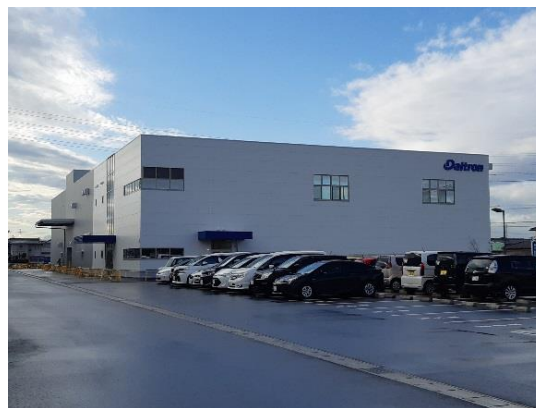
中部第二工場外観
