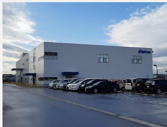
中部第二工場完成写真
