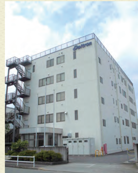
機械装置工場 多摩(東京都西多摩郡瑞穂町)
